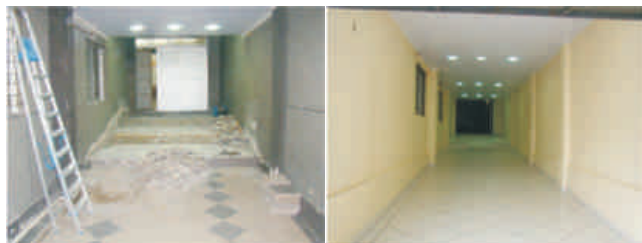
Durante a obra
