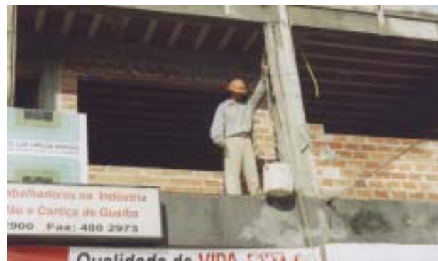
Neste mês de junho reiniciou-se mais uma etapa da obra do 2º piso no Sindicato. Nesta etapa está previsto levantar as paredes e o reboco.
